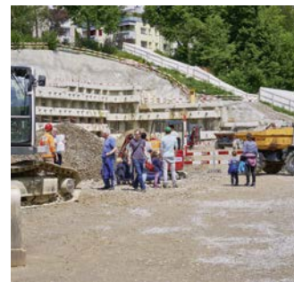
... und verschiedene Baumaschinen bewundern, welche für den Bau der dortigen Baugrube eingesetzt werden.
