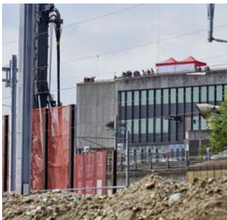
Von der Einsteinterrasse hat man einen guten Blick auf die Baustelle Eilgut.
