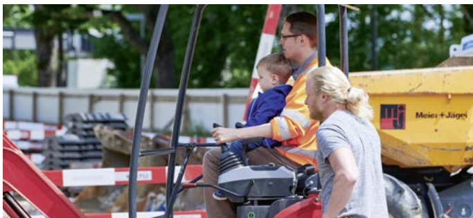
Auf der Baustelle Hirschenpark konnten Mutige selber einmal einen Bagger bedienen ...
