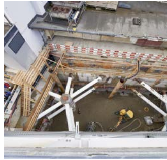
... von wo aus der neue RBS-Bahnhof gebaut wird.
