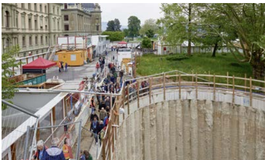
Auch die SBB-Baustelle auf der Grosse Schanze hat viele Interessierte angezogen.
