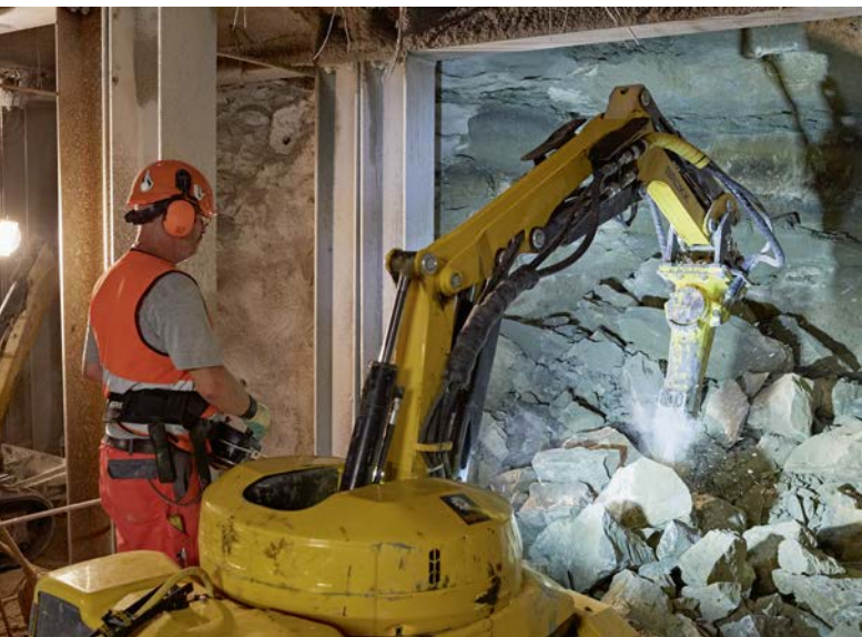
Die Baustelle unterhalb des «PostParc Mitte».
