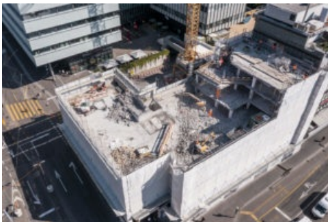
Baustelle grosse Schanze.
