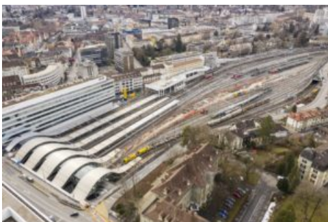
Baustelle Installationsplattform Schanzenstrasse.
