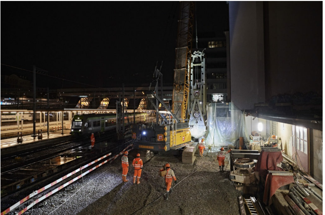
Installationsplatz Laupenstrasse: Von hier aus erfolgt der Bau des eigentlichen RBS-Tiefbahnhofs.
