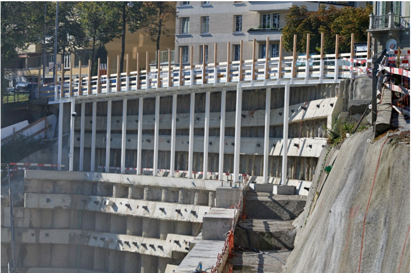
Die Stahlkonstruktion bei der Bushaltestelle «Bierhübeli» erinnert stark an einen Balkon.
