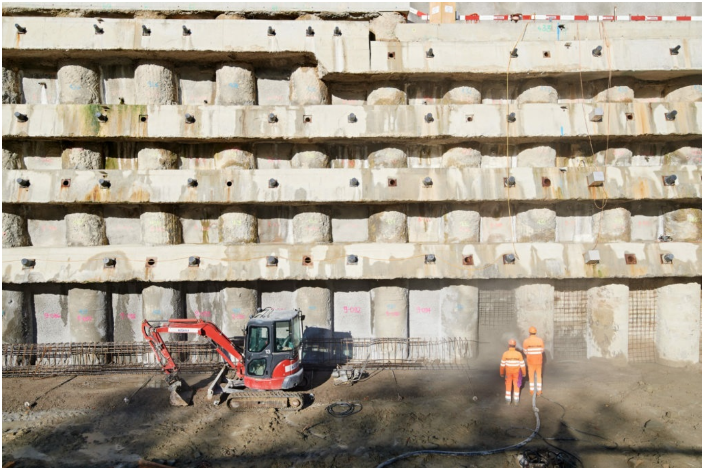
Die Wand rund um die Baugrube Hirschenpark. Es handelt sich dabei um eine sogenannte Bohrpfehlwand.
